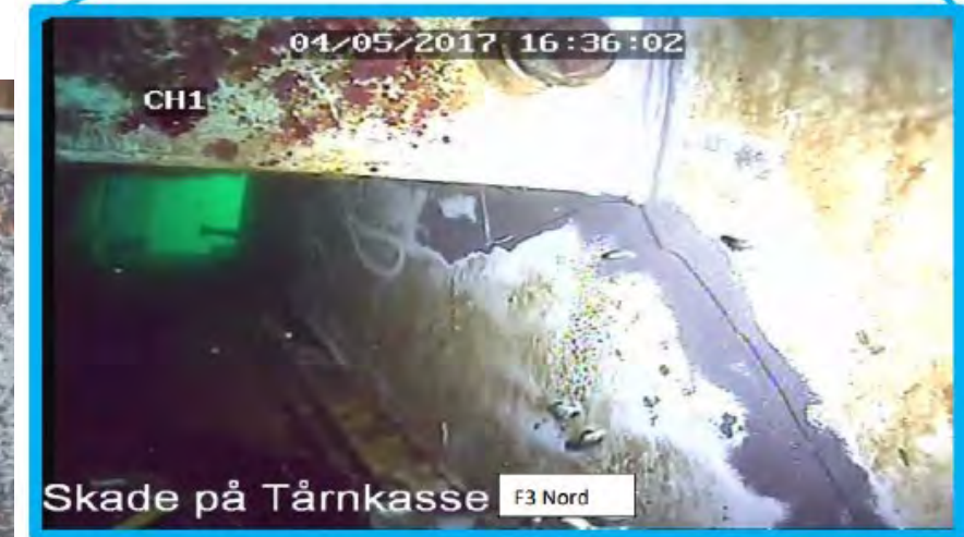
Figur 2 – Sprekkeområder i Tårnkasse inn mot Elementene
